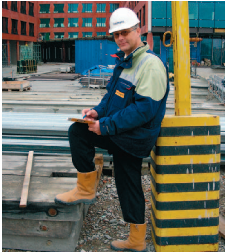
Hoofduitvoerder Henk Duijzer maakt een OOG-ronde op de bouwplaats.
